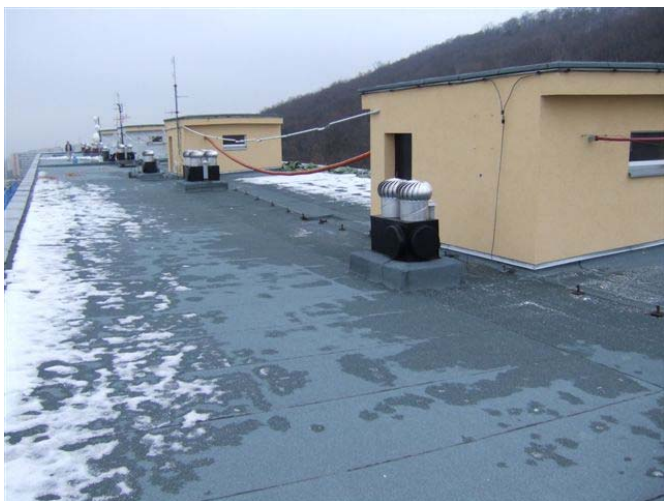
Střecha objektu – po rekonstrukci
