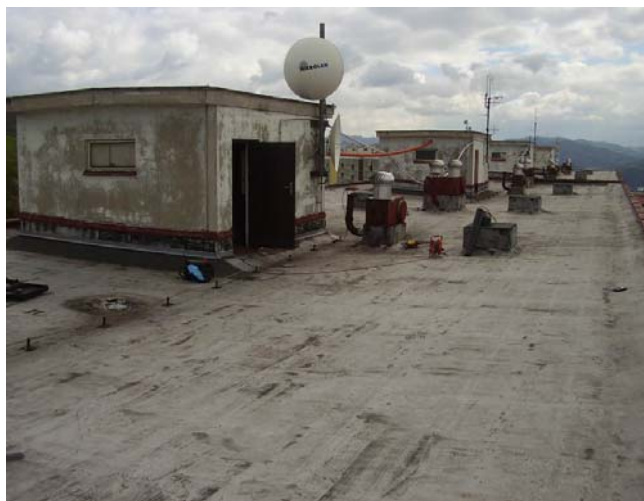
Střecha objektu - původní
