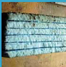
04 | vzorek ze střechy B rozdělený na vrstvy pro zjištění dílčích hmotnostních vlhkostí jednotlivých vrstev, z povrchu desky odstraněna vrstva plastbetonu
